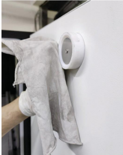
A panelszigetelés megtisztítása
